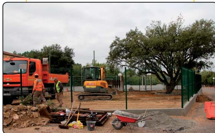
**Chemin des Écureuils** : renforcement du réseau d'eau potable, pose d'un poteau incendie.
