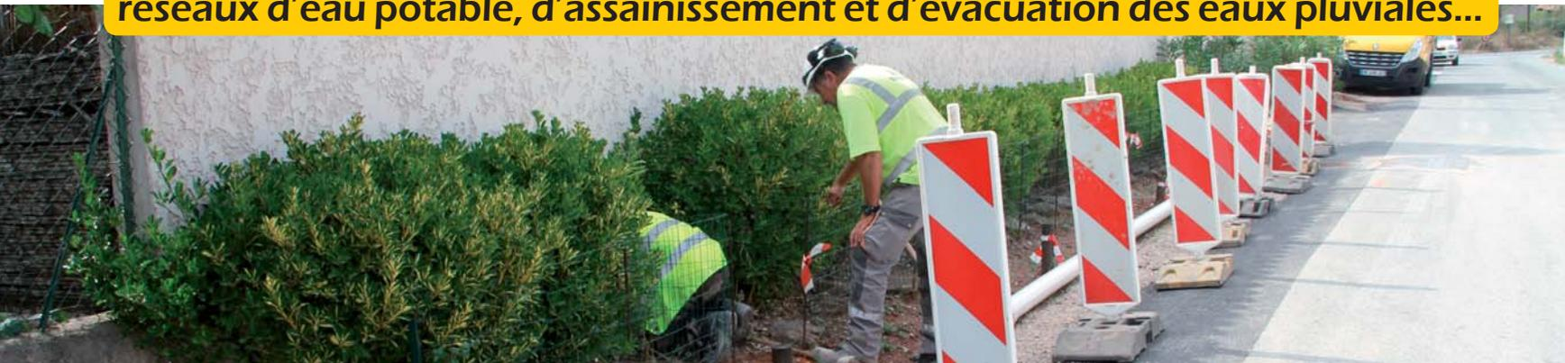
**Chemin de Chaumes** : élargissement de la voie par alignement des rives de chaussée, grattage, dérochage, afin de faciliter – le cas échéant – le passage des camions de secours dans le cadre du PPRIF.
